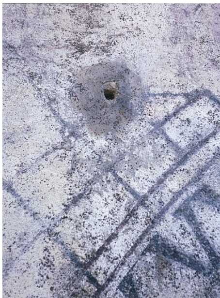
Obr. 6 — Otvor po chybějícím ukazaleli levých západních hodin.
