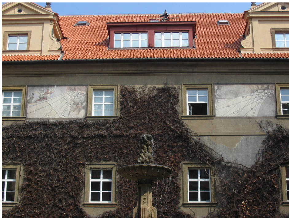
Obr. 11 — Dvojice slunečních hodin na západní stěně Révového nádvoří Klementina.
